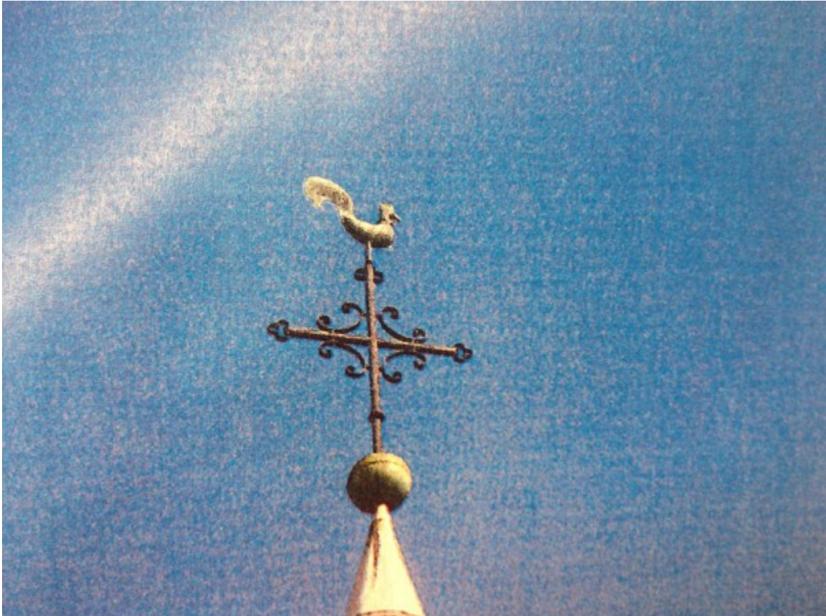
Croix au sommet de la flèche du clocher
