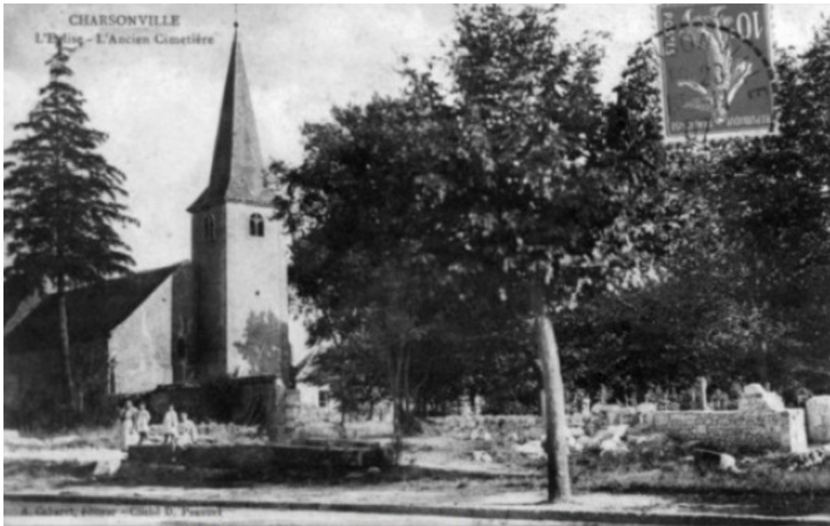
L'élargissement de la route côté place a été réalisé Le presbytère est démoli et son jardin a disparu On aperçoit encore des croix dans l'ancien cimetière
