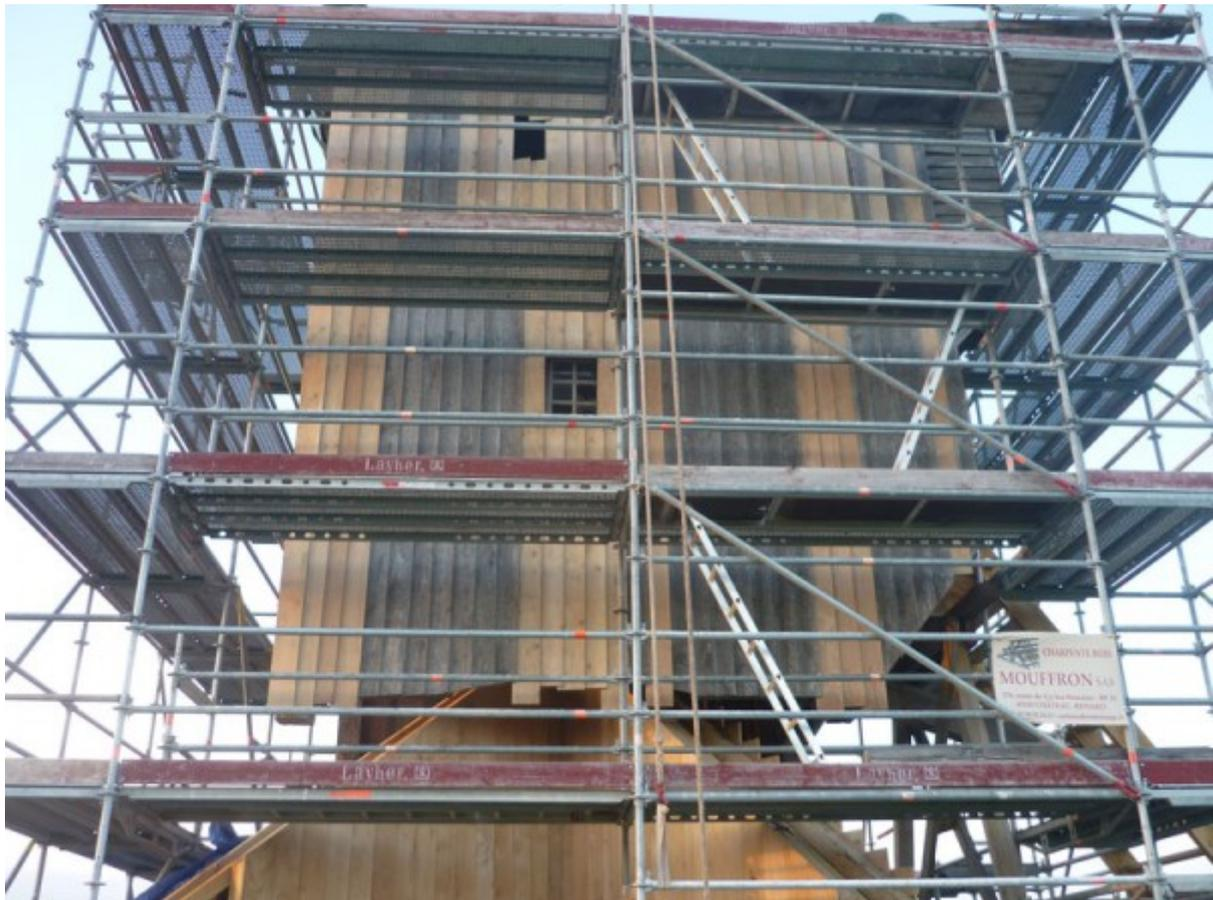
Fig. 10.11. Le tour de la tour se termine à la place sur le pivot. L'arbre moteur et les ailes sont en cours de fabrication et rejoindront
