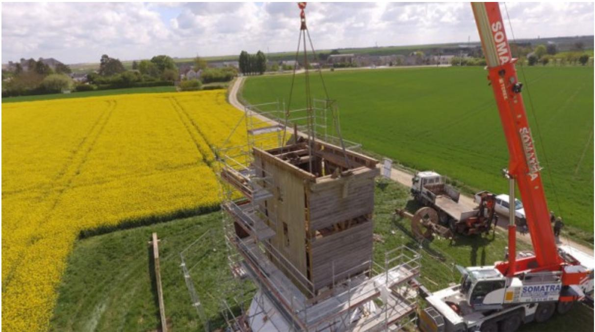
Des planches et bandes fatiguées sont remplacées et l'escalier extérieur, permettant d'accéder au corps du moulin, est
