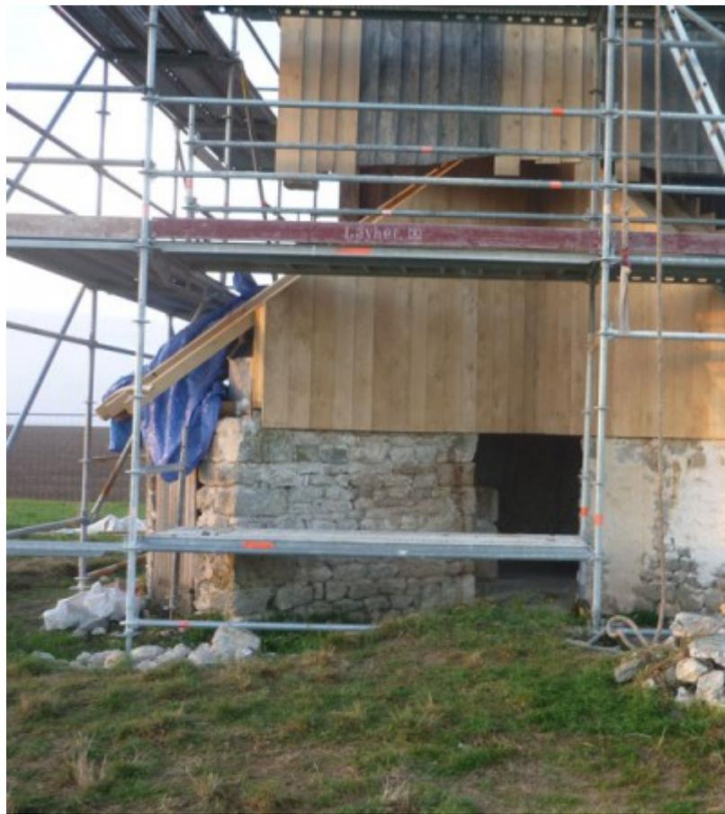
Fig. 10.10. Le tour de la tour se termine à la place sur le pivot. L'arbre moteur et les ailes sont en cours de fabrication et rejoindront
